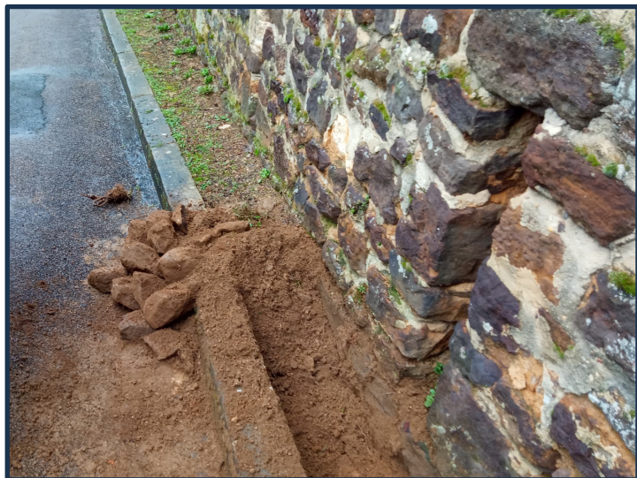
Décaissement de la zone
