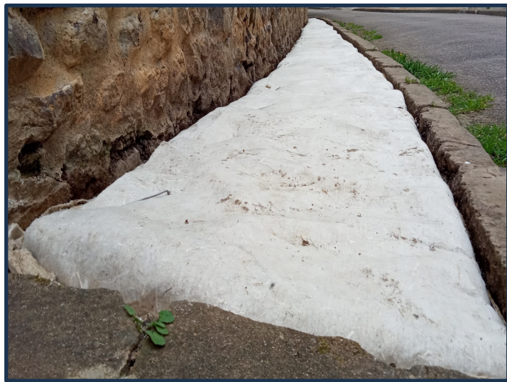
Couverture de la terre par la toile Géochanvre
